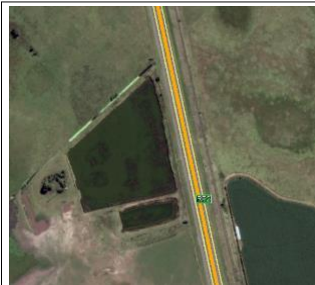
Foto 73. Cantera en progresiva 139+000 a 139+500
