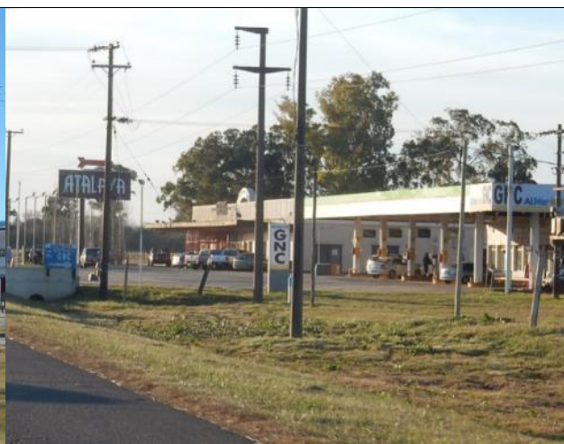
Foto 163. Estación de servicio de Gas (GNC) (Chascomús. Progresiva 122+600)
