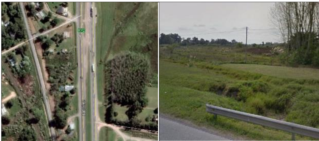
Foto 38 y Foto 39. Arroyo sin nombre en progresiva 123+300
