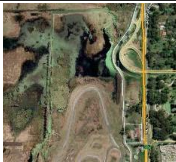
Foto 86. Laguna temporaria en progresiva 209+300 a 209+800
