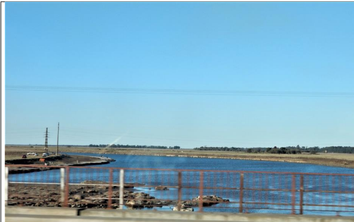
Foto 52, 53, 54, 55, 56 y 57. Río Salado en progresiva 166+900
