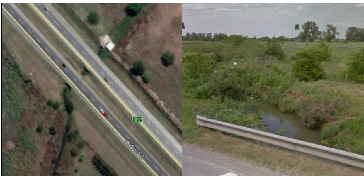
Foto 1 y Foto 2. Arroyo sin nombre en progresiva 56+800
