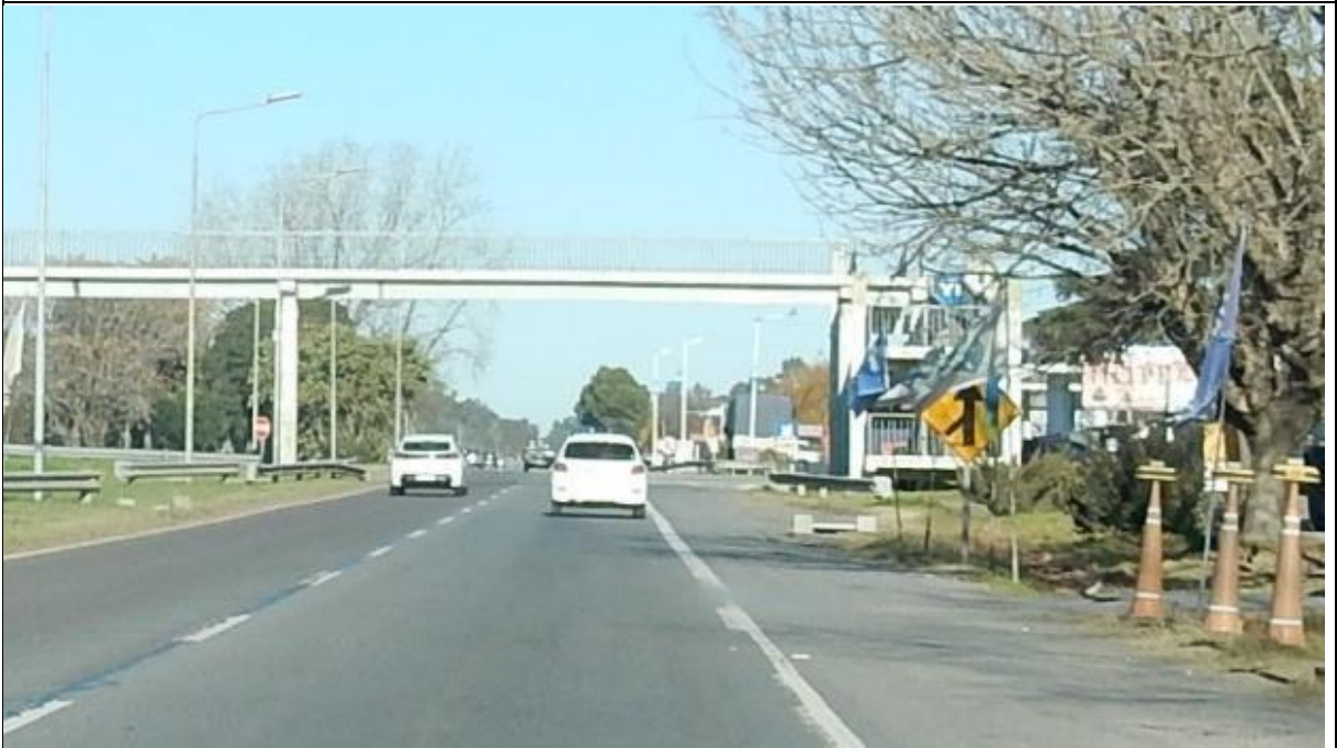
Foto 216. Pasarela peatonal en progresiva 182+000. Vista de detalle
