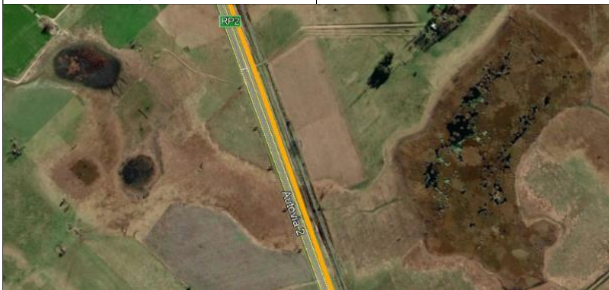
Foto 82. Lagunas temporarias en progresiva 161+100
