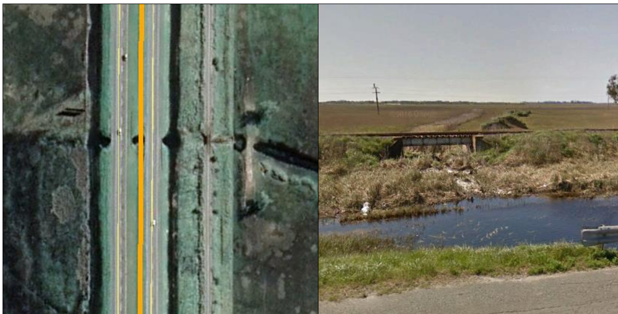
Foto 60 y Foto 61. Canal sin nombre en progresiva 184+800
