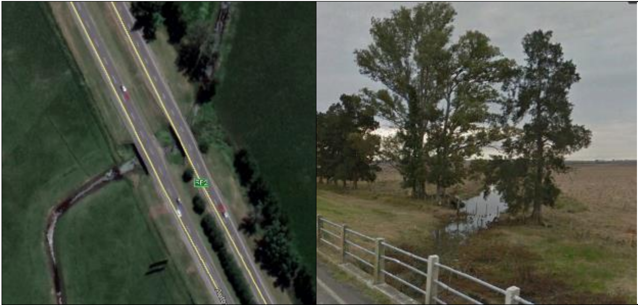
Foto 3 y Foto 4. Arroyo sin nombre en progresiva 67+150
