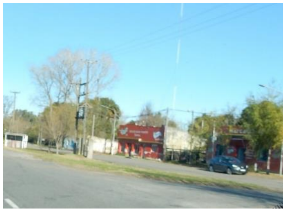
Foto 200. Colectora en progresiva 195+900
