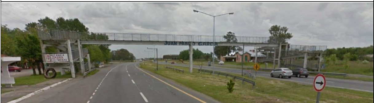
Foto 217. Pasarela peatonal en progresiva 195+000. Vista general
