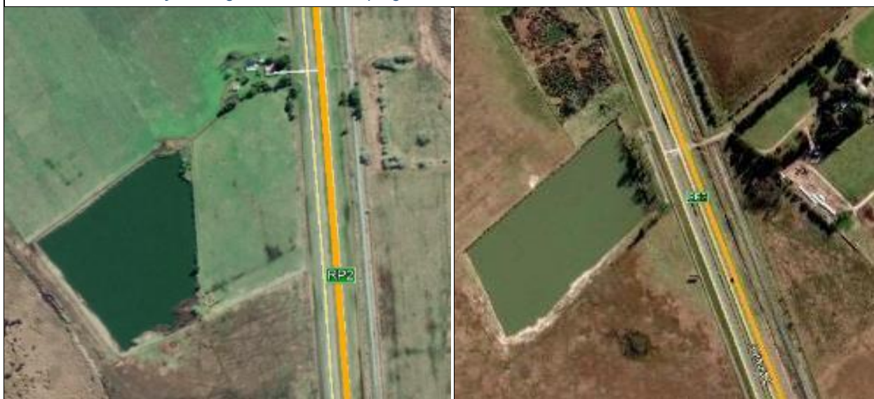
Foto 80. Cantera en progresiva 149+900 a 150+200
