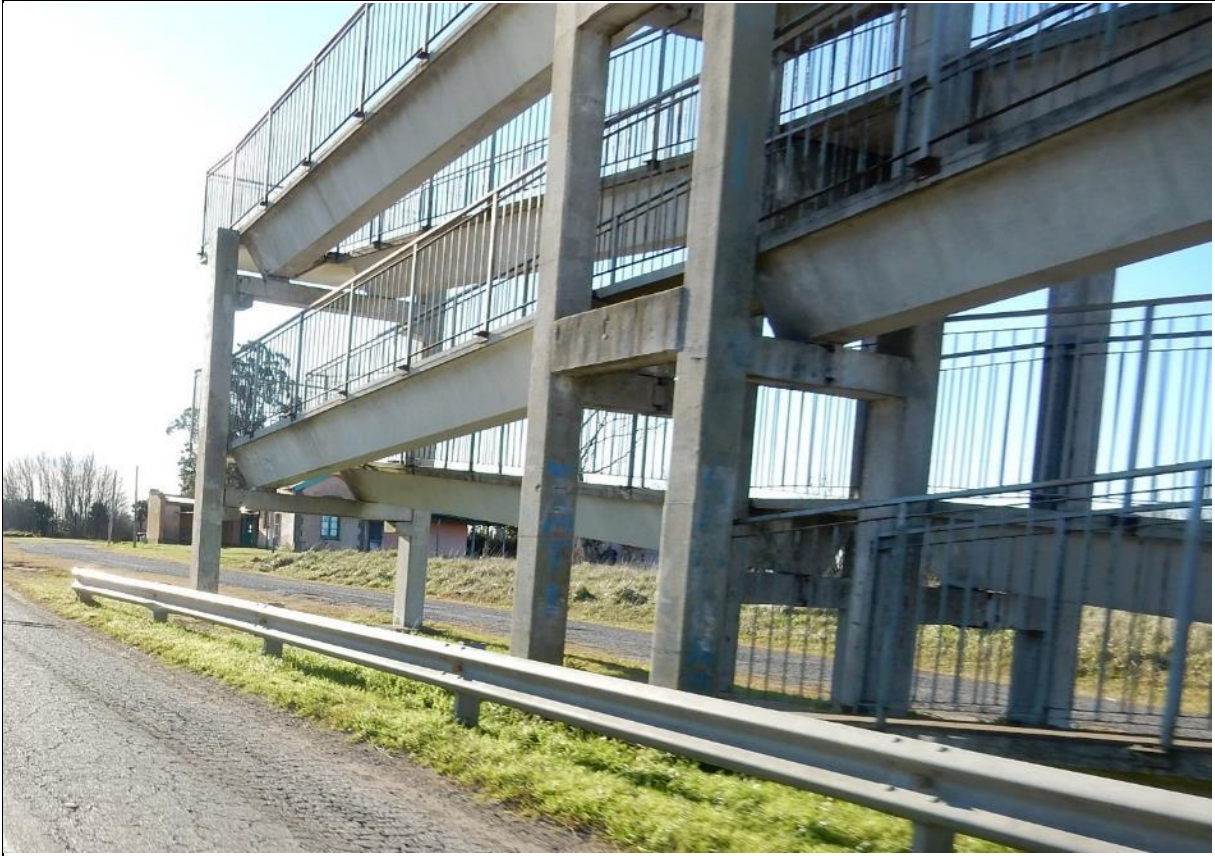
Foto 218. Escalera de la pasarela peatonal en progresiva 195+000
