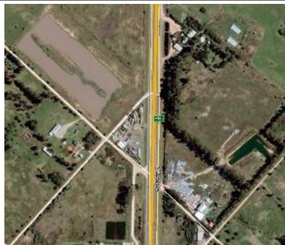
Foto 36. Canteras en progresiva 117+600
