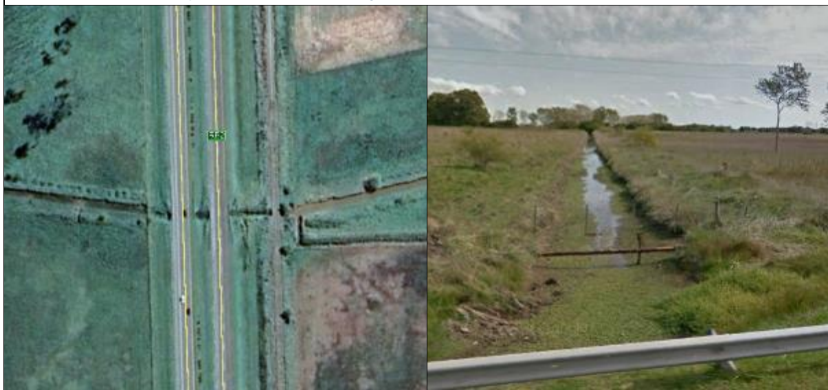
Foto 58 y Foto 59. Canal sin nombre en progresiva 176+500
