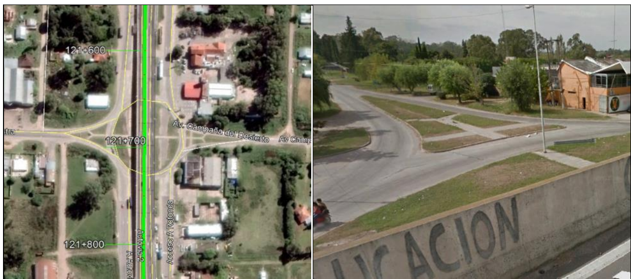
Foto 184 y Foto 185. Intersección RP N°2 con RP N°58 en progresiva 121+700
