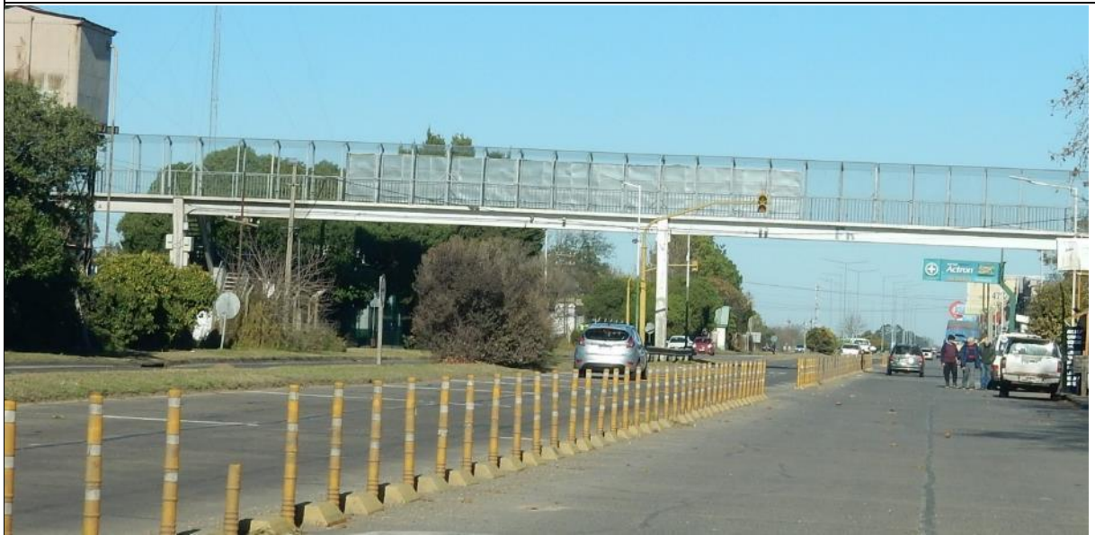
Foto 214. Pasarela peatonal en progresiva 156+023. Vista de detalle
