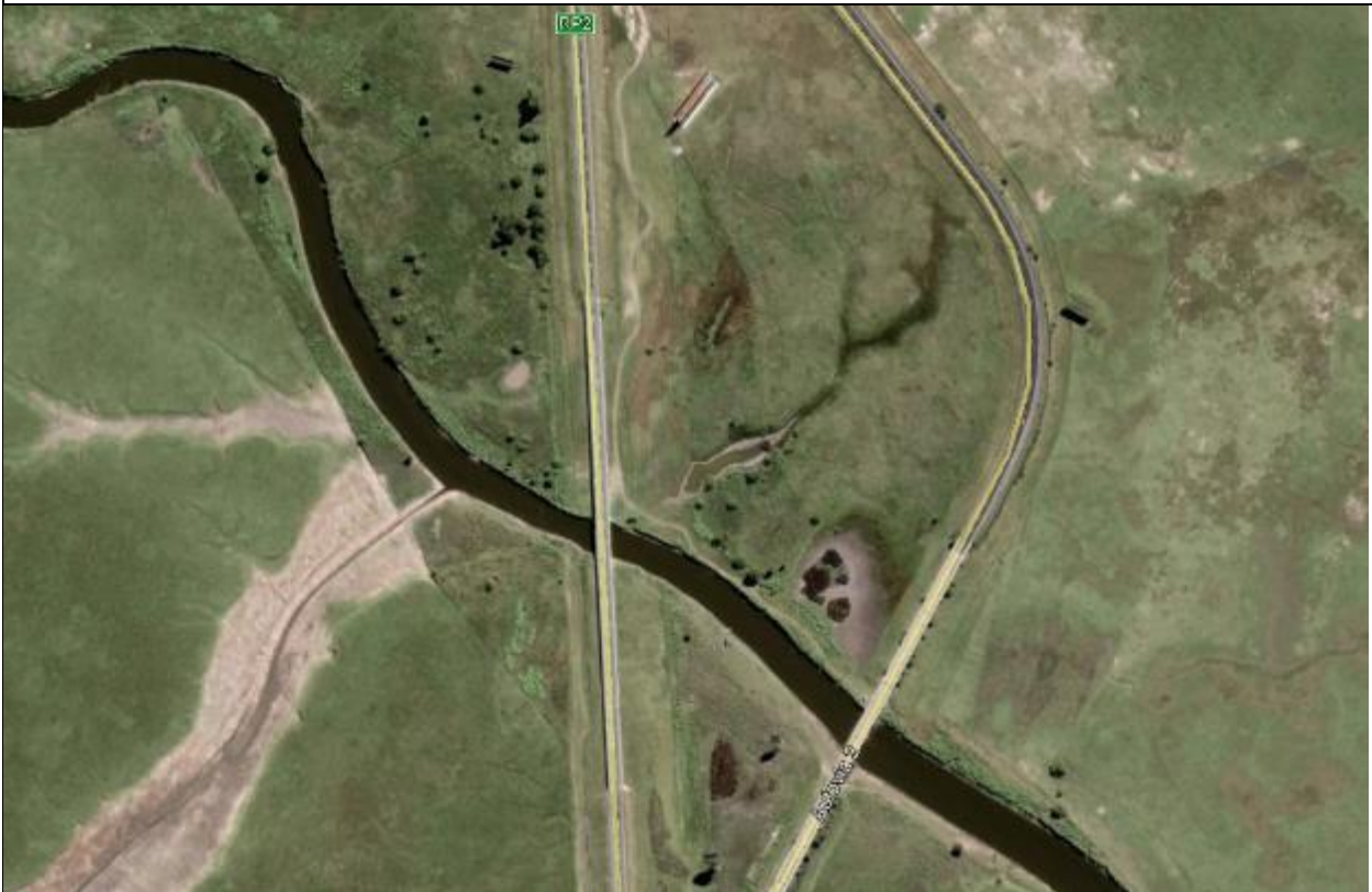
Foto 7 y Foto 8. Canal sin nombre en progresiva 76+800
