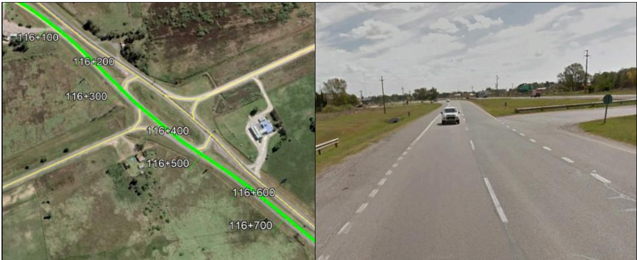
Foto 179 y Foto 180. Intersección RP N°2 con RP N°20 en Progresiva 116+400
