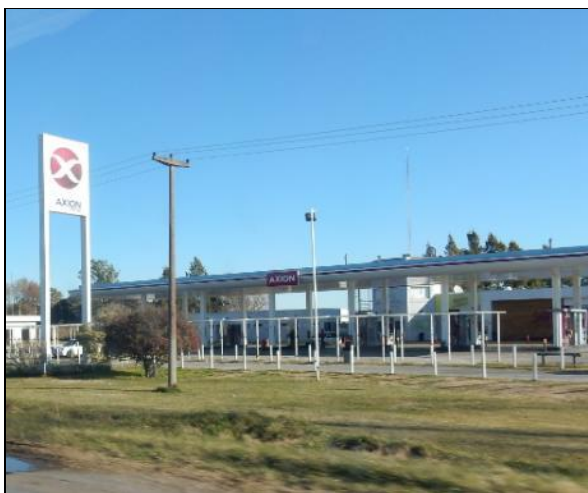
Foto 162. Estación de servicio Axión (Dolores. Progresiva 203+100)
