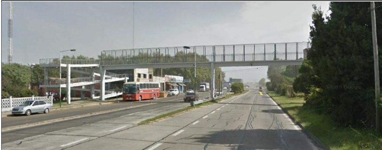
Foto 213. Pasarela peatonal en progresiva 156+023. Vista general
