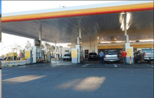
Foto 165. Estación de servicio Shell (Chascomús. Progresiva 115+550)
