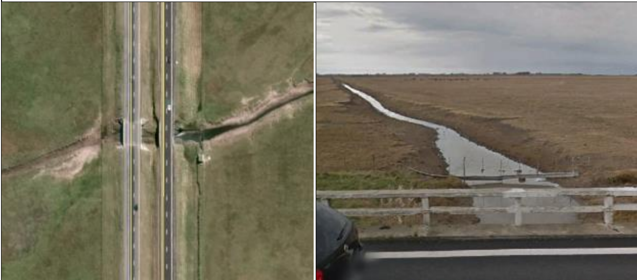
Foto 12 y Foto 13. Canal en progresiva 94+950
