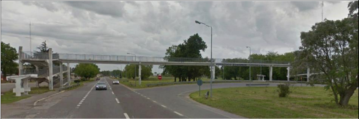
Foto 215. Pasarela peatonal en progresiva 182+000. Vista general
